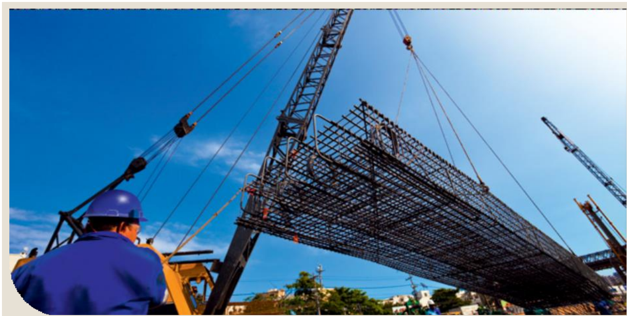
Figura 2 - APS sendo posicionada para posterior concretagem
