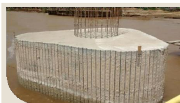
Figura 7 - À esquerda, blocos com APS e Fôrma Incorporada antes da concretagem; à direita, os mesmos blocos já concretados
