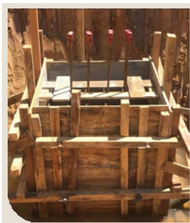
Figura 4 – À esquerda, elemento estrutural com fôrma de madeira, que exigirá desfôrma; à direita, peça com Fôrma Incorporada
