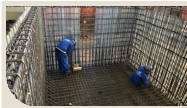
Figura 6 - APS e Fôrma Incorporada em: à esquerda, canaleta; à direita, reservatório
