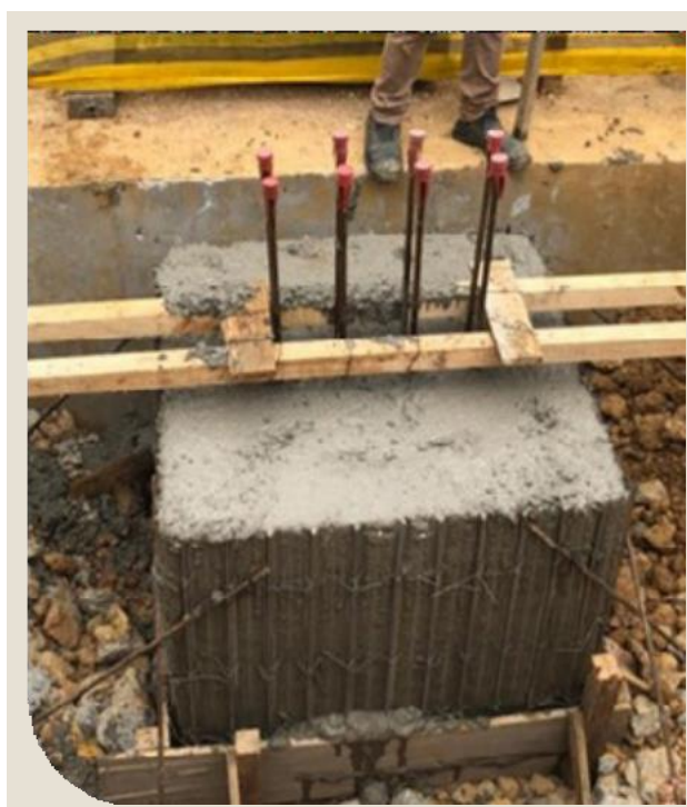
Figura 4 – À esquerda, elemento estrutural com fôrma de madeira, que exigirá desfôrma; à direita, peça com Fôrma Incorporada
