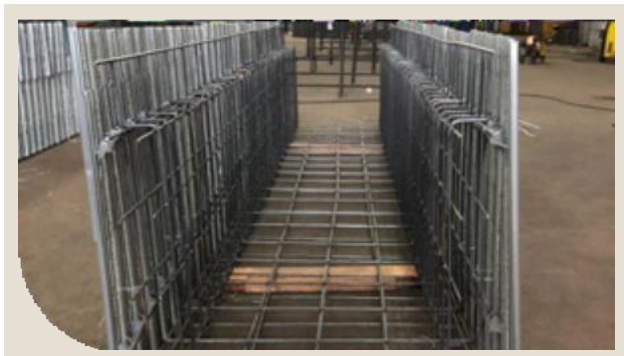
Figura 6 - APS e Fôrma Incorporada em: à esquerda, canaleta; à direita, reservatório
